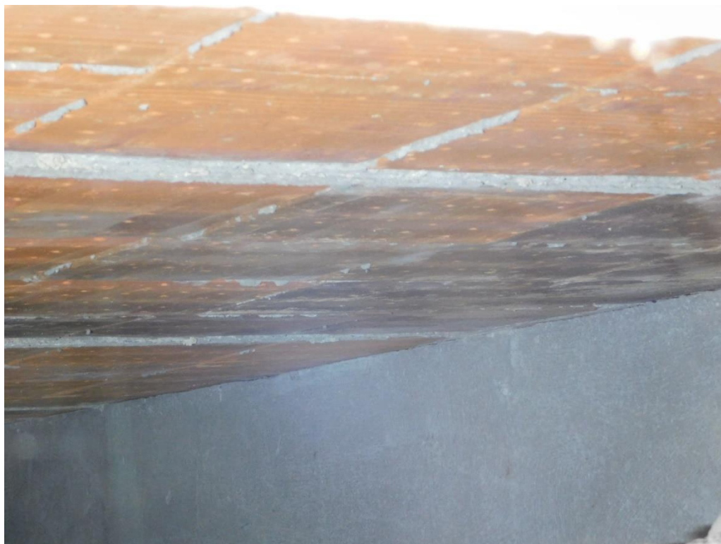
Obr. 14 - Pravé žebro pro podepření keramických panelů
