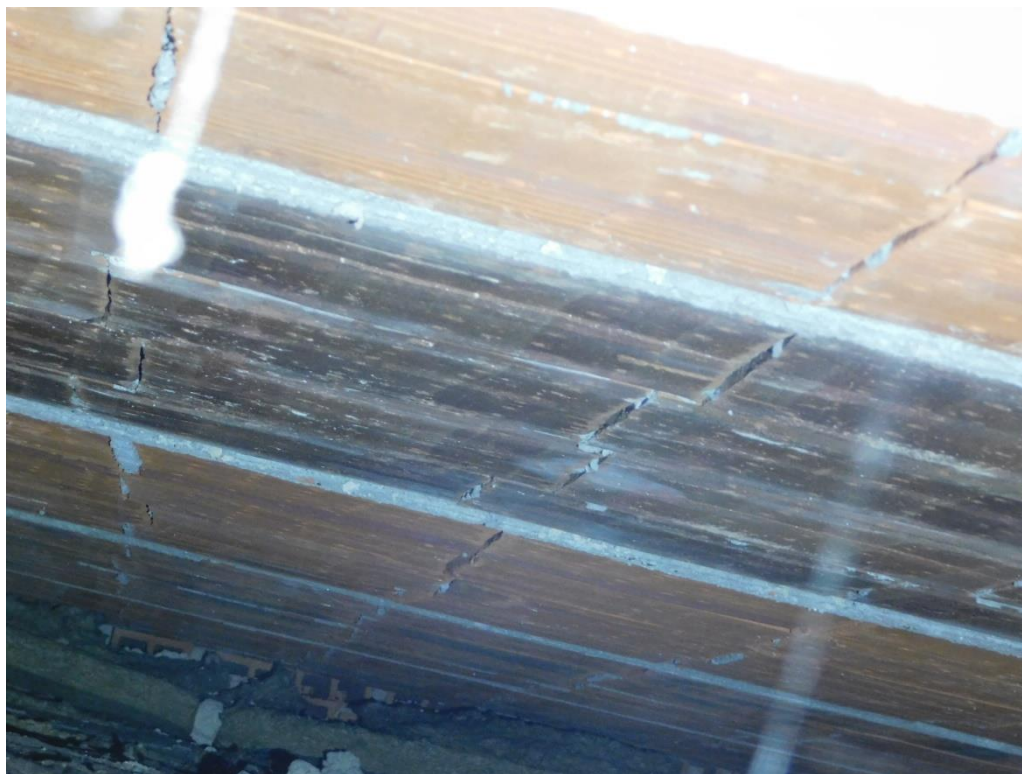
Obr. 12 - Spodní povrch keramických panelů (4 řady keram.vložek )
