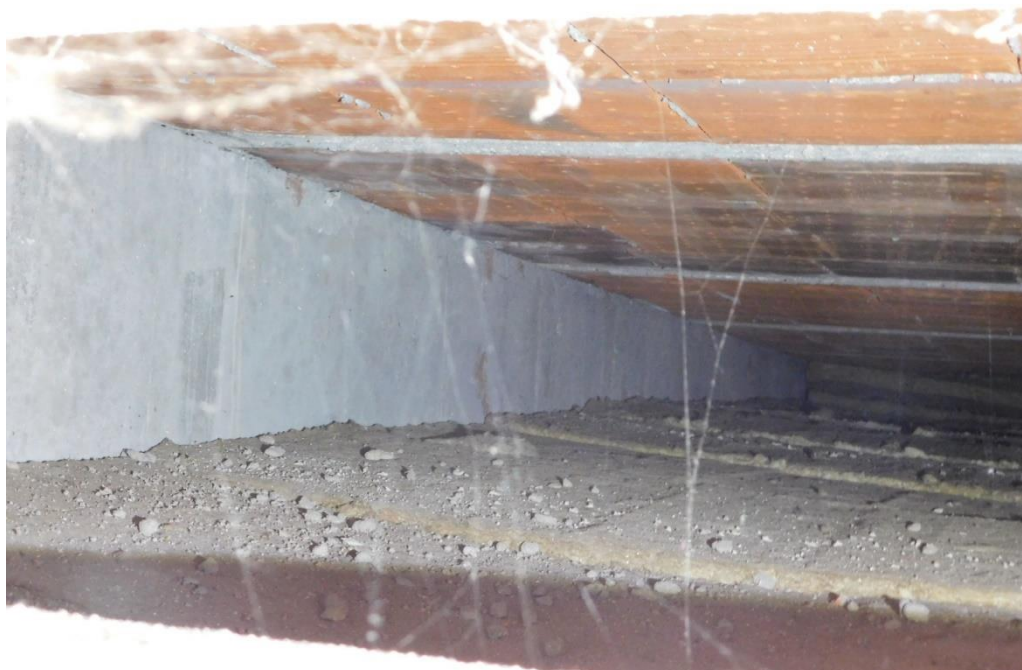
Obr. 13 - Levé žebro pro podepření keramických panelů
